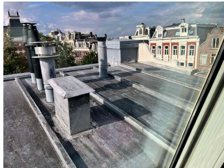
Zinken dak, matige staat, vele doorvoeren.
