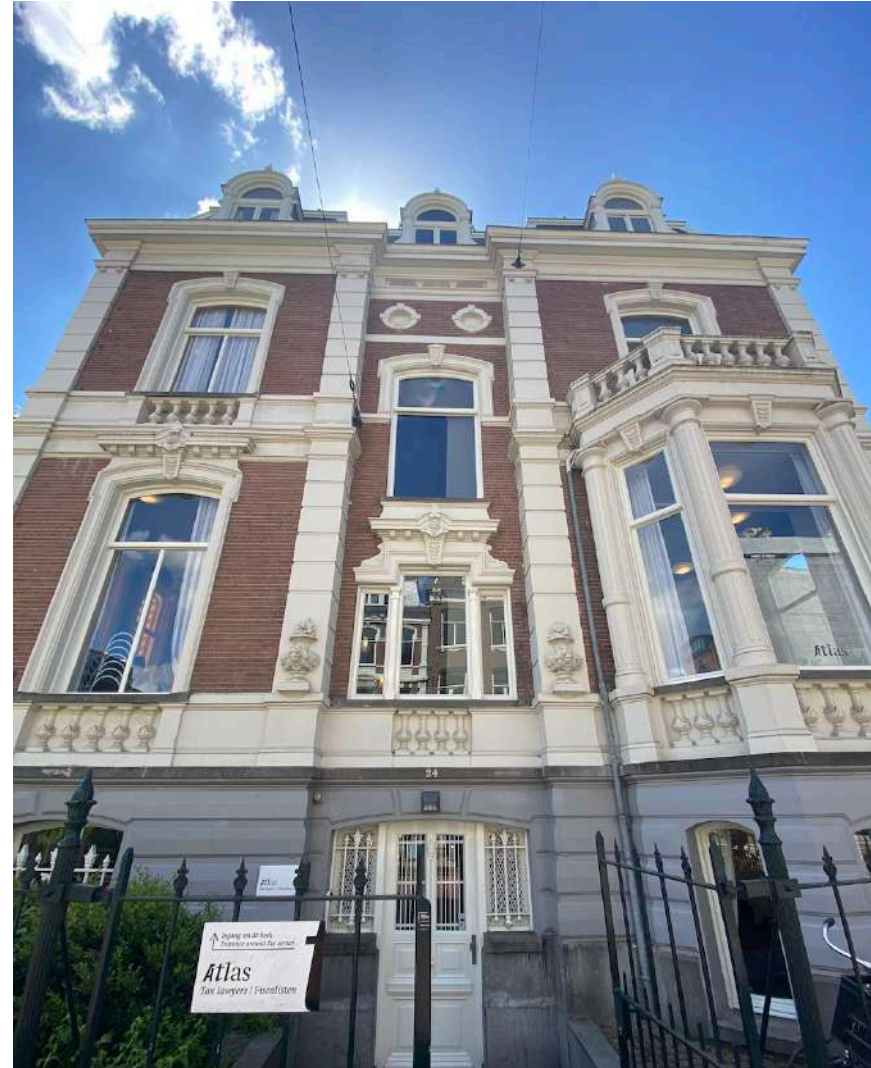
Gevel zijde Weteringschans (straat).
